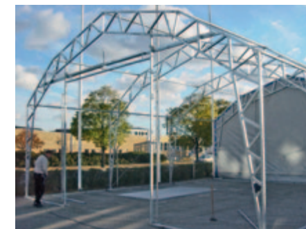
Hallin rungon asennus
