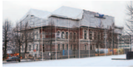
LGS-sääsuoja on muunneltavissa eri kattomuotoihin
