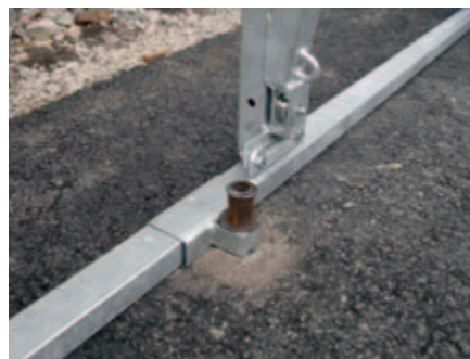
Hallin ankkurointi tiivistettyyn sora- tai asfaltti-pohjaan
