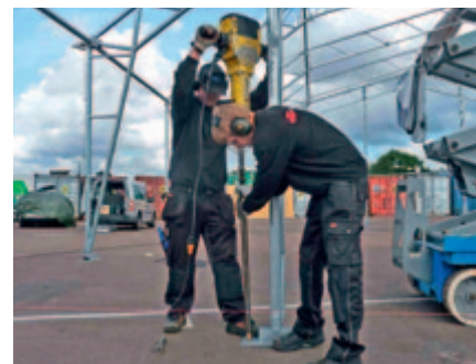
Hallin rungon ankkurointi
